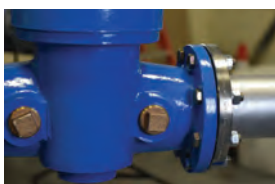
Pudotuspesä rakenne 1 1/2" NPT-liittimillä varustettuna
