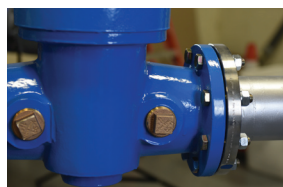
Pudotuspesä rakenne 1 1/2" NPT-liittimillä varustettuna
